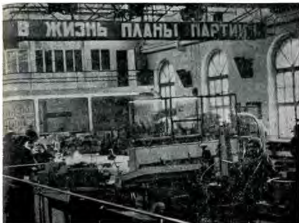
В механическом цехе депо.
