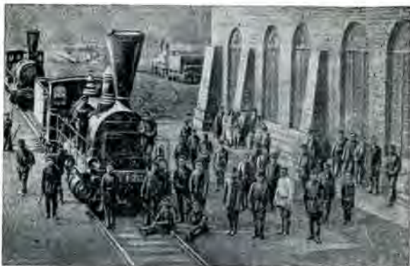
У здания Петропавловского депо. 1896 год.
